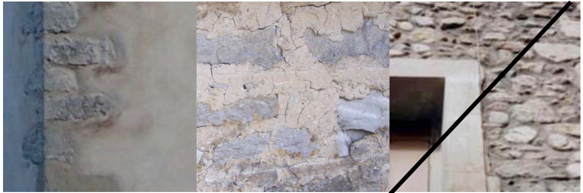
Enduit épais avec chaînage apparent sans surépaisseur
