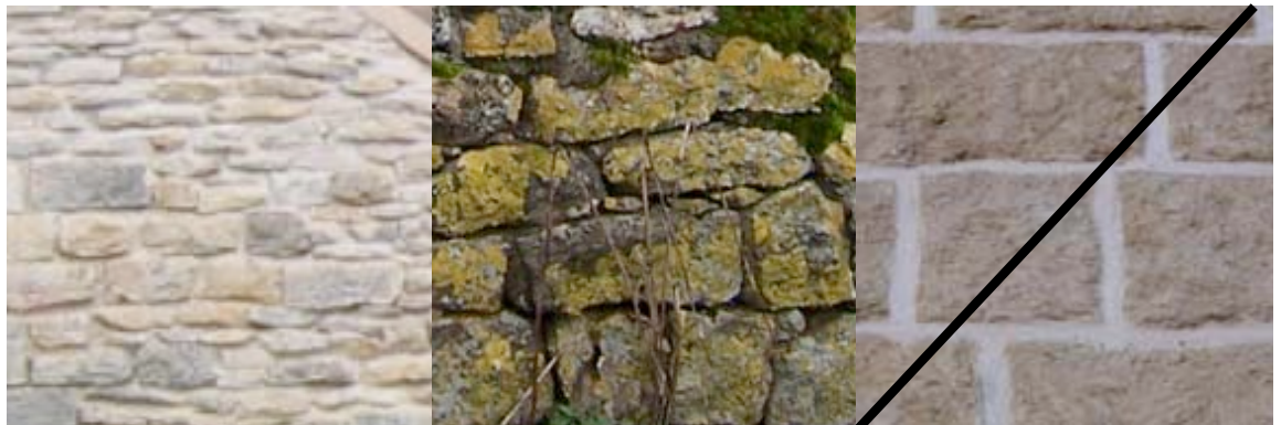
Joitoiement dans le même ton que la pierre
