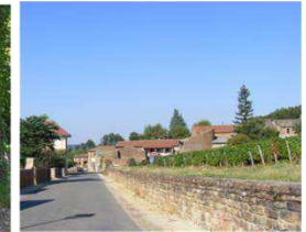
Mur en pierre à Clessé
