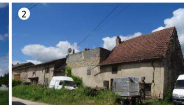
Ilots dégradés dans le Faubourg
