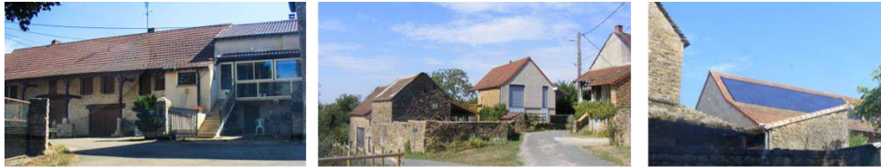
Installation d'une veranda à l'emplacement de galeries mâconnaises.
