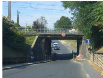
Passage sous la voie ferrée (rue de la résistance)
