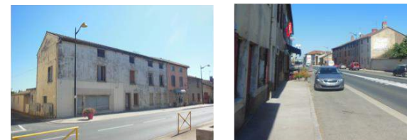
Îlot urbain dégradé
