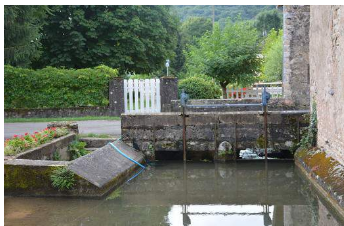
Lavoir de Sagy-le-bas, rue du moulin Jeandet
