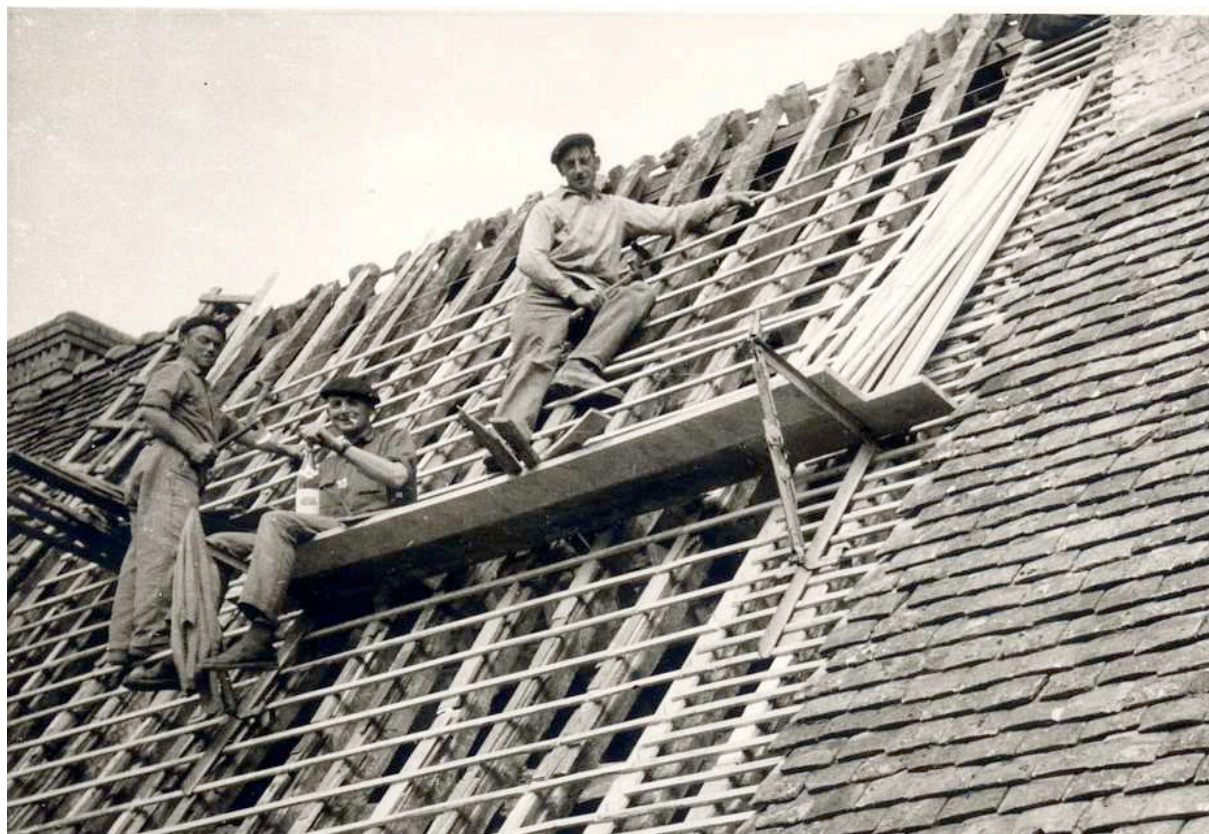
Les charpentiers de l'entreprise Chambard sur le toit du château de Plottes au début des années 60 : Marius Fomagé, Louis Ladame et Aimé Perret
