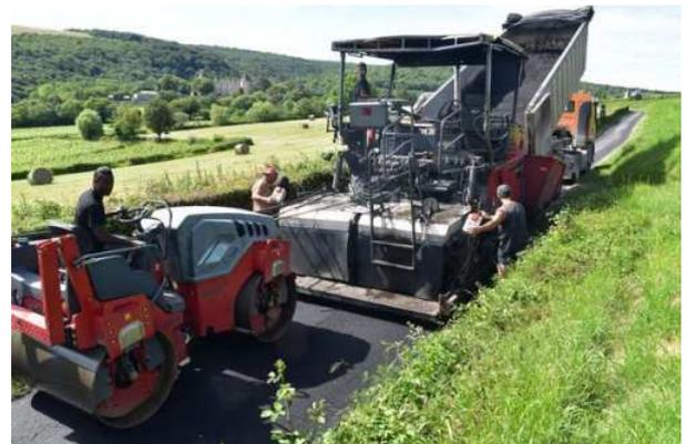
La nouvelle couche est aplanie par un compacteur qui réalise des allers-retours en permanence jusqu'à la fin de la section.
