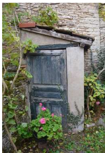
Toilettes à Collonges
