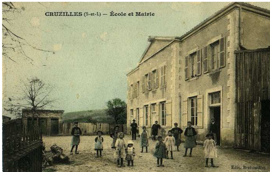
Toilettes de l'école au fond de la cour
