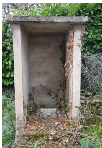
Toilettes à Collonges
