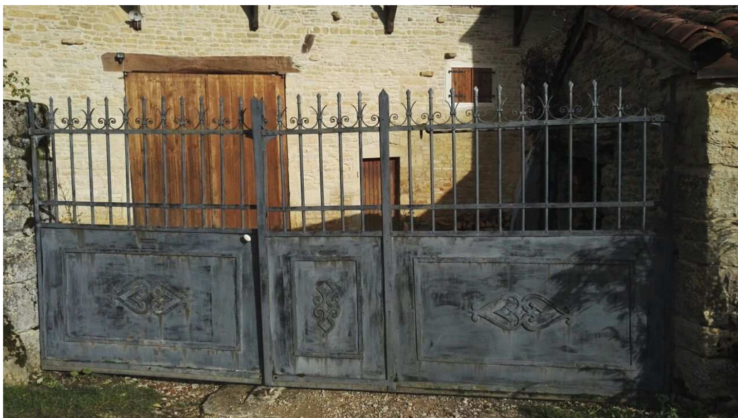
Portail, rue des Moines
