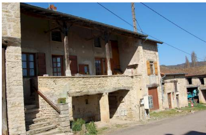
Façades ensemble de bâtiments pour habitation et activités agricoles
