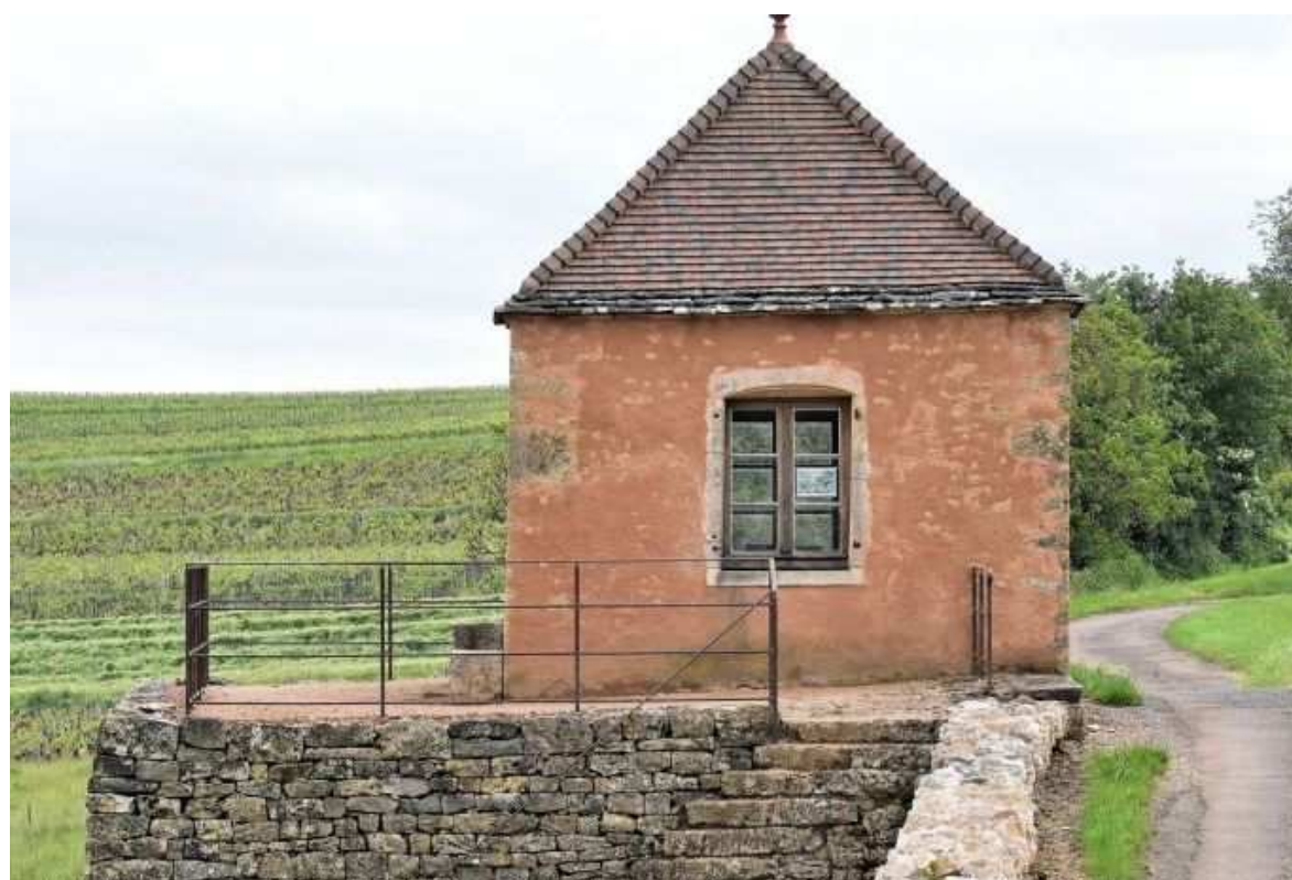
Enduit à "pierres vues" murs de la Guinguette
