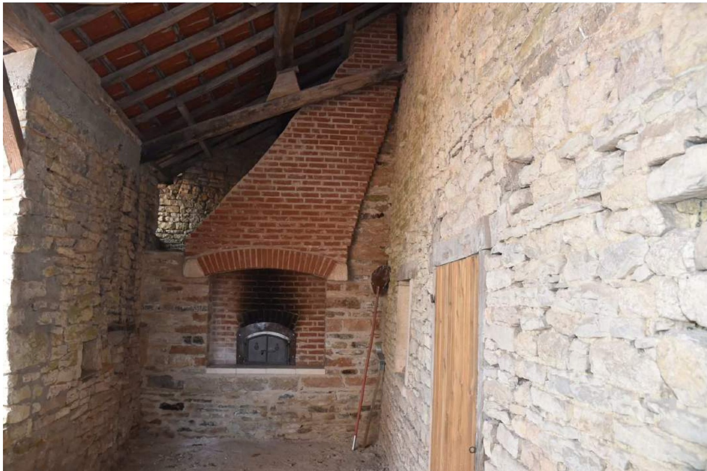
Cheminée du four à pain
