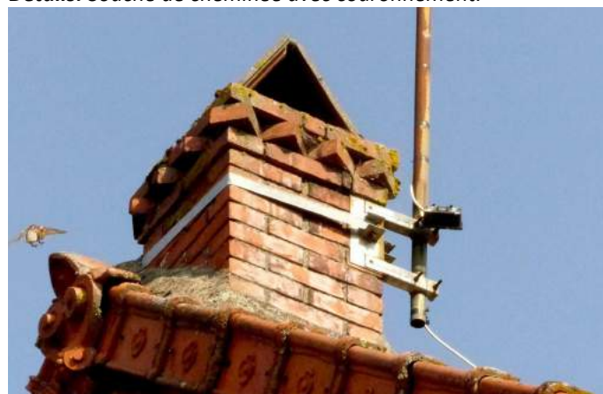
Souche de cheminée avec couronnement.
