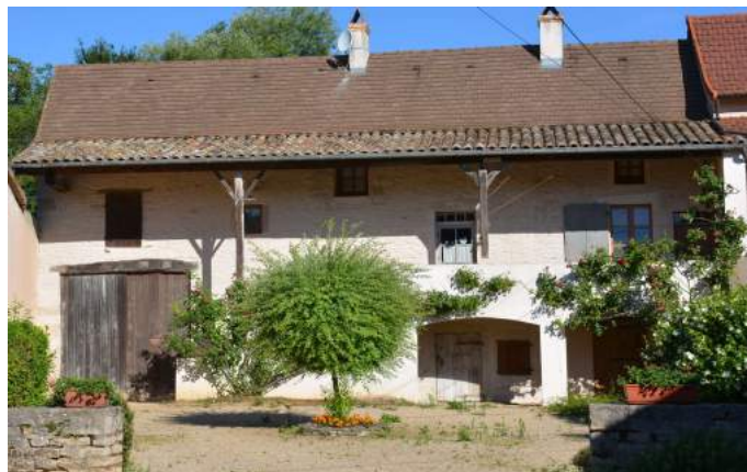
Façade ancienne maison de vigneron
